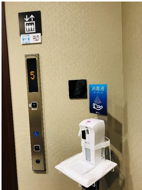
各階エレベーター乗り場に配置
